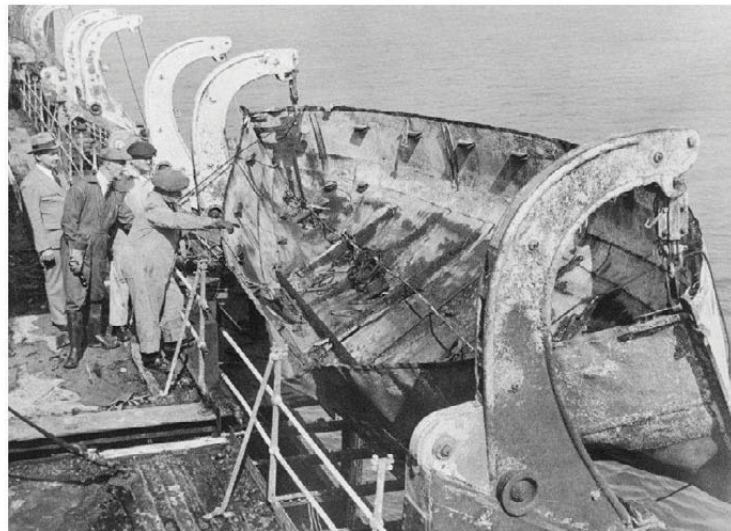
MALT FAST: Bare seks av 12 livbåter var mulig å få på vannet. Årsaken var overdrevent vedlikehold og maling som gjorde heiseanordninger ubrukelige.
