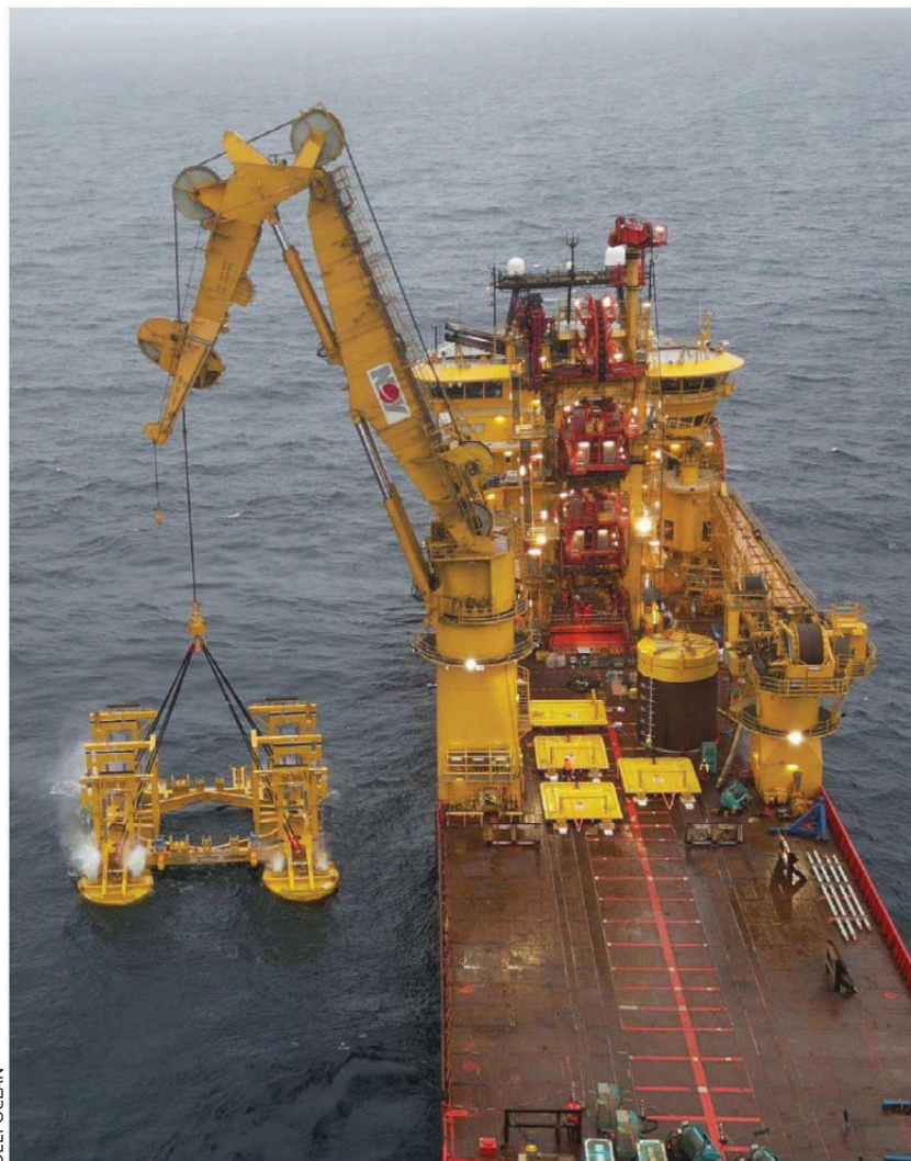
TUNGT LØFT: Det svært komplekse enkeltløftet utnyttet omtrent 95 prosent av kranens kapasitet.
