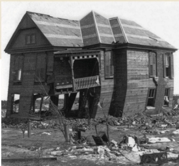
ENESTE GJENVÆRENDE HUS: Byens strandbebyggelse ble blåst og skylt vekk fra jordens overflate. Dette trehuset var den eneste bygningen som sto igjen, og det med nød og neppe, i et område på flere kilometer.
