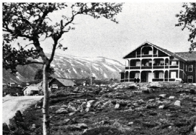
GROTLI HOTELL: Her tok de britiske og tyske flyverne inn etter nedskytingen og nødlandingen. Hotellet slapp uskadet fra krigshandlingene, men ble betydelig modernisert etter frigjøringen.
