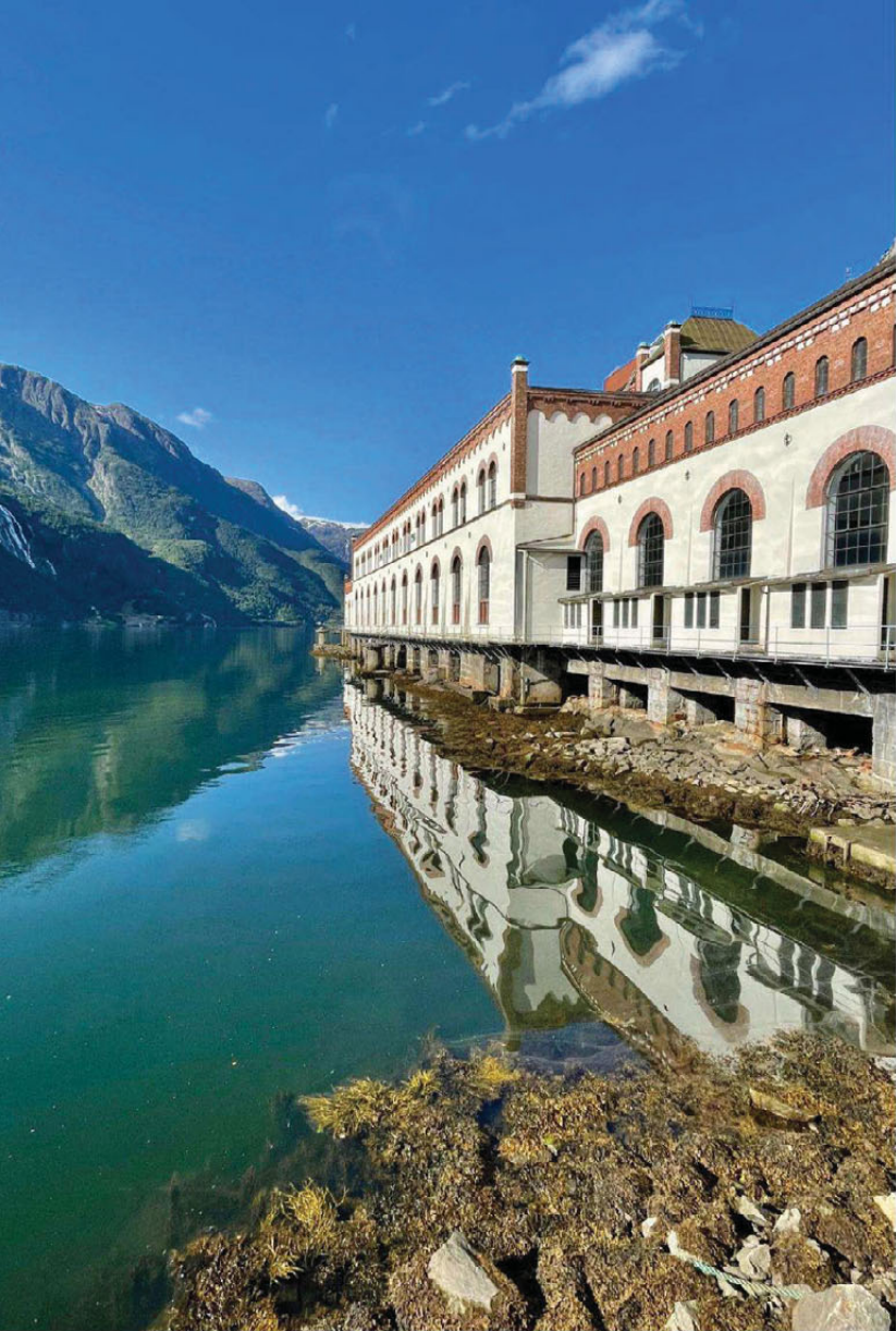
FOREGANGSKRAFTVERK: Tyssø I var det første anlegget i Nord-Europa som ble bygd med magasin og en så stor fallhøyde som 400 meter. Rørgaten fra Lilletopp og fordelingsbassenget ble lagt i et svært vanskelig terreng.
