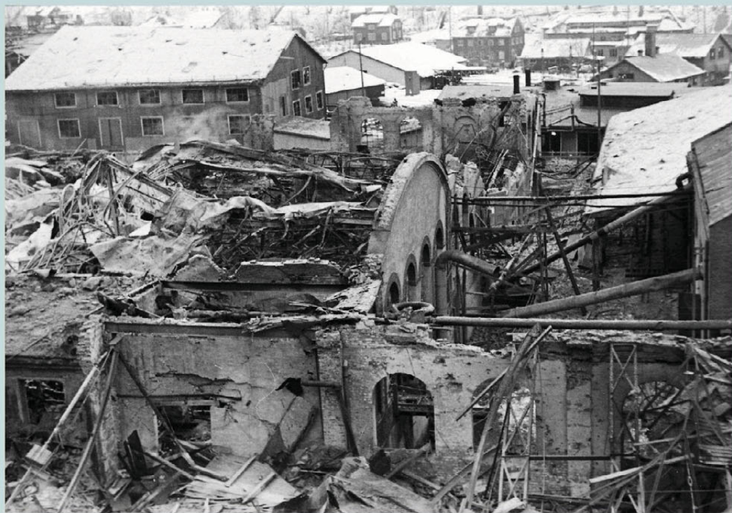
ØDELEGGELSER: Bomberegnet over Vemork og Rjukan la mange bygninger i ruiner i november 1943.
