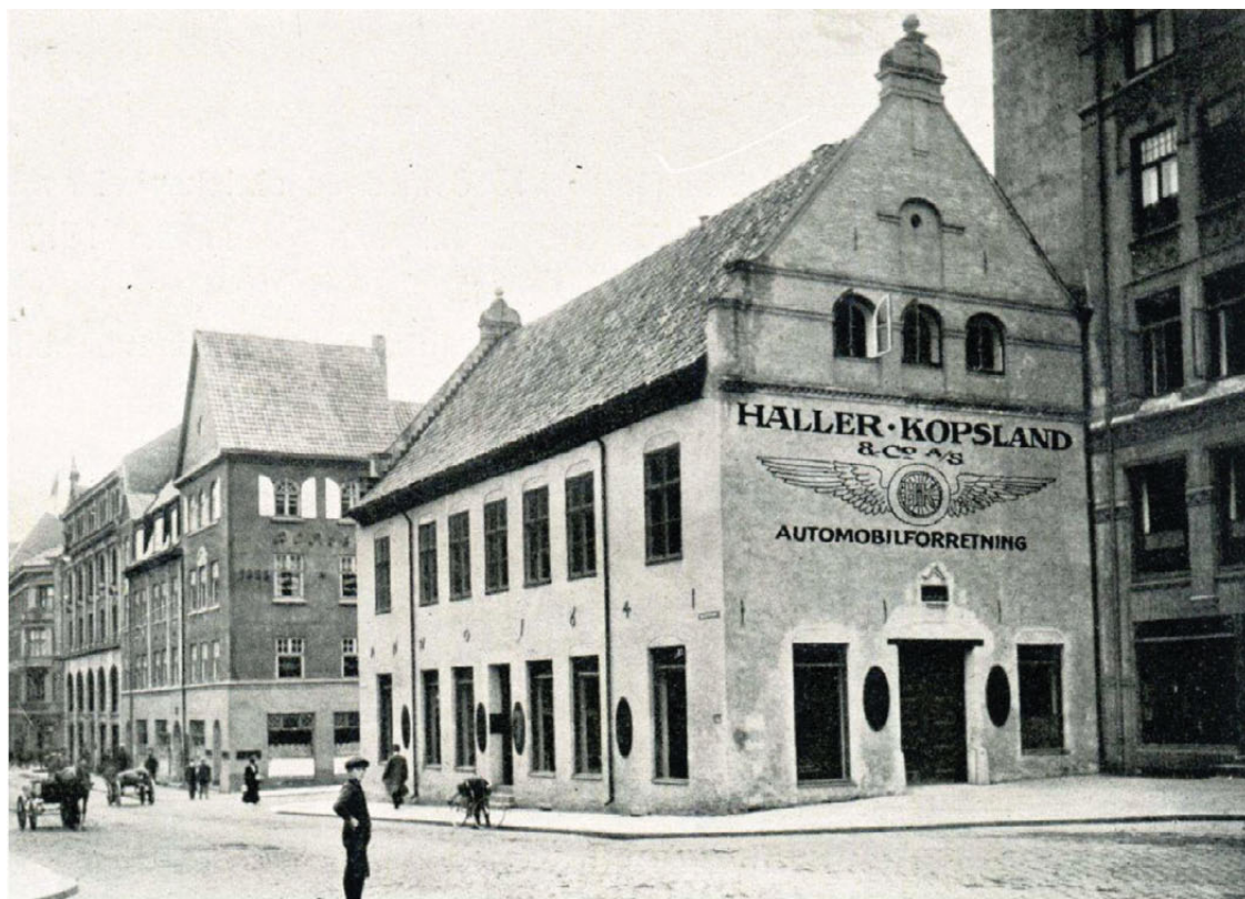
Historisk bygning: Nedre Slottsgate 1, hovedstadens første rådhus, med firmanavnet til Haller, Kopsland & Co. A/S på vestveggen. Man må lure på hvordan de fikk biler inn i utstillingslokalet. Det er bare en ganske smal dobbeltdør på tverrveggen.
