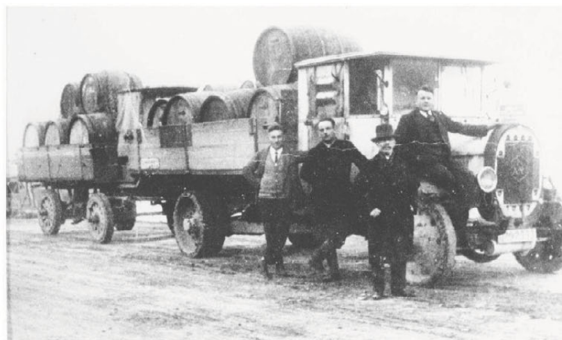
Skål!: En NAG (senere overtatt av Büssing) type 5/2 med 80-100 HK med påbygg og tilhenger fra Wackenhut, lastet med vintønner.
