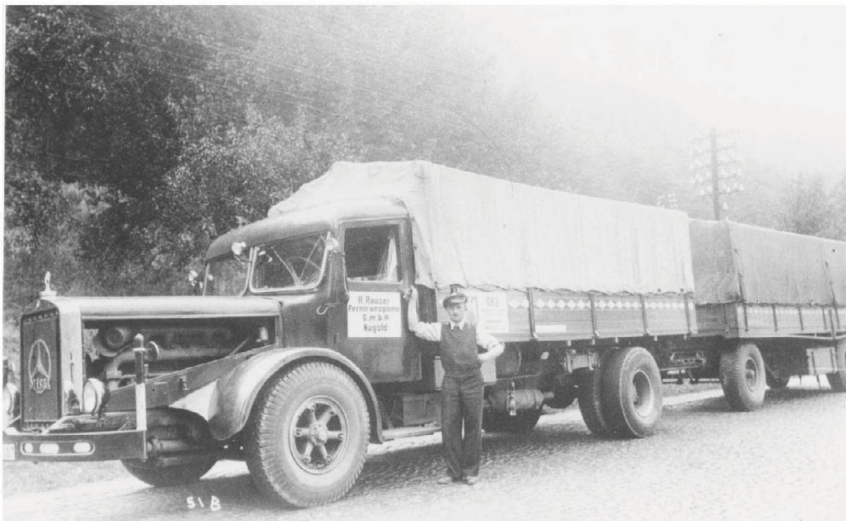
Vintertid: Stolt viser sjåføren av denne Mercedes-Benz L 5000 (nyttelast 5 tonn, 6 syl., 120 hk) frem det tildekkede motorpanseret som beskytter mot kulden.
