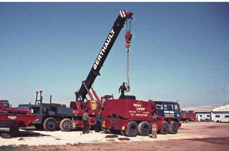
Vekt for traction: Ved depotet til Trans-Europ heiser mobilkranen containeren med 8 tonn ballast på Willeme 8x4. Det er viktig å ha maksimalt marktrykk.
