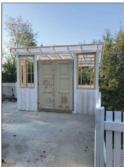
Utestue med dobbeldør: Utestua ble bygget med utgangspunkt i en gammel dobbeldør som paret fikk av naboen. Taket er av gjennomsiktige pvc-plater.
