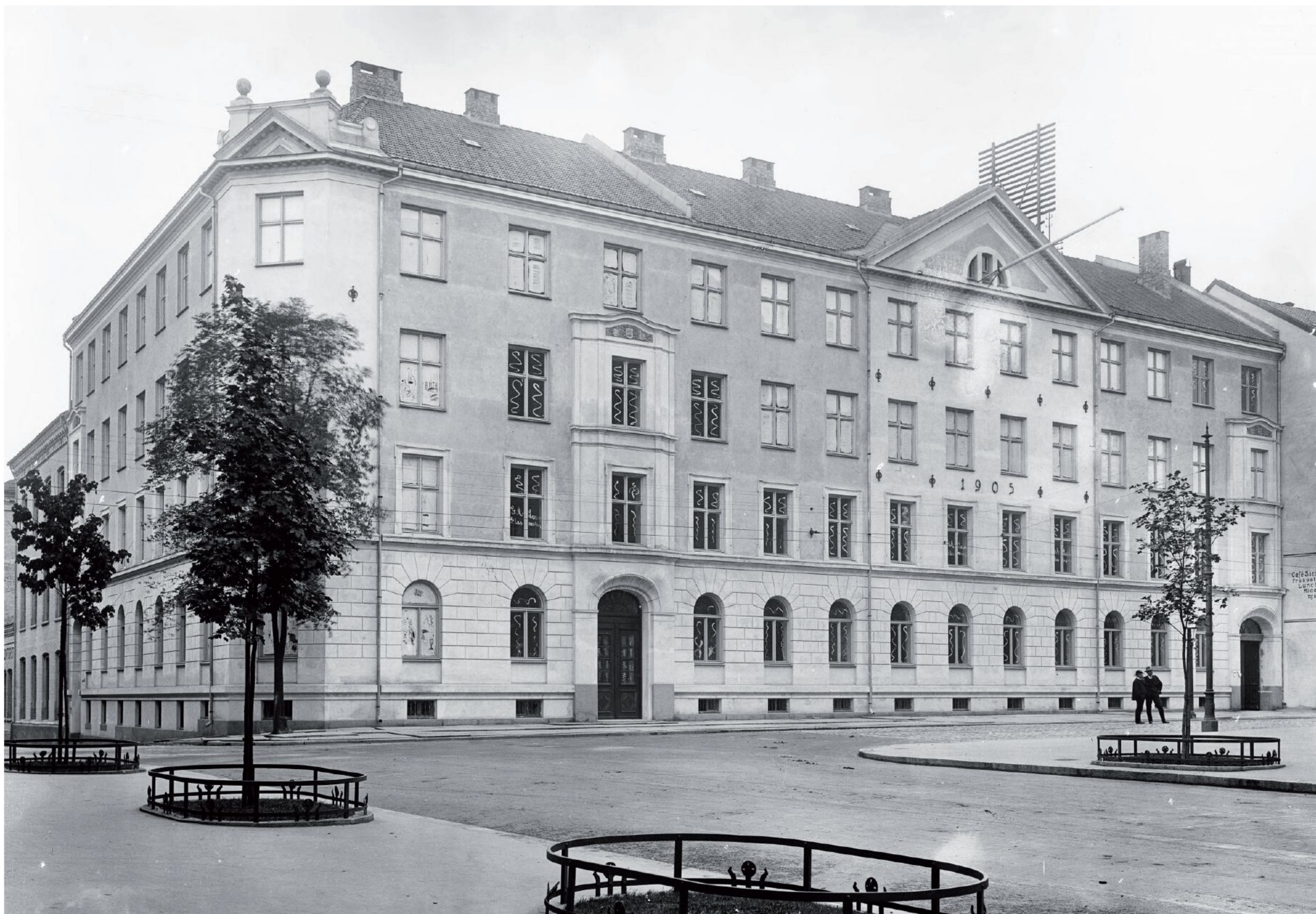
Akersgata 55 som ble sprengt av Oslogjengen.
