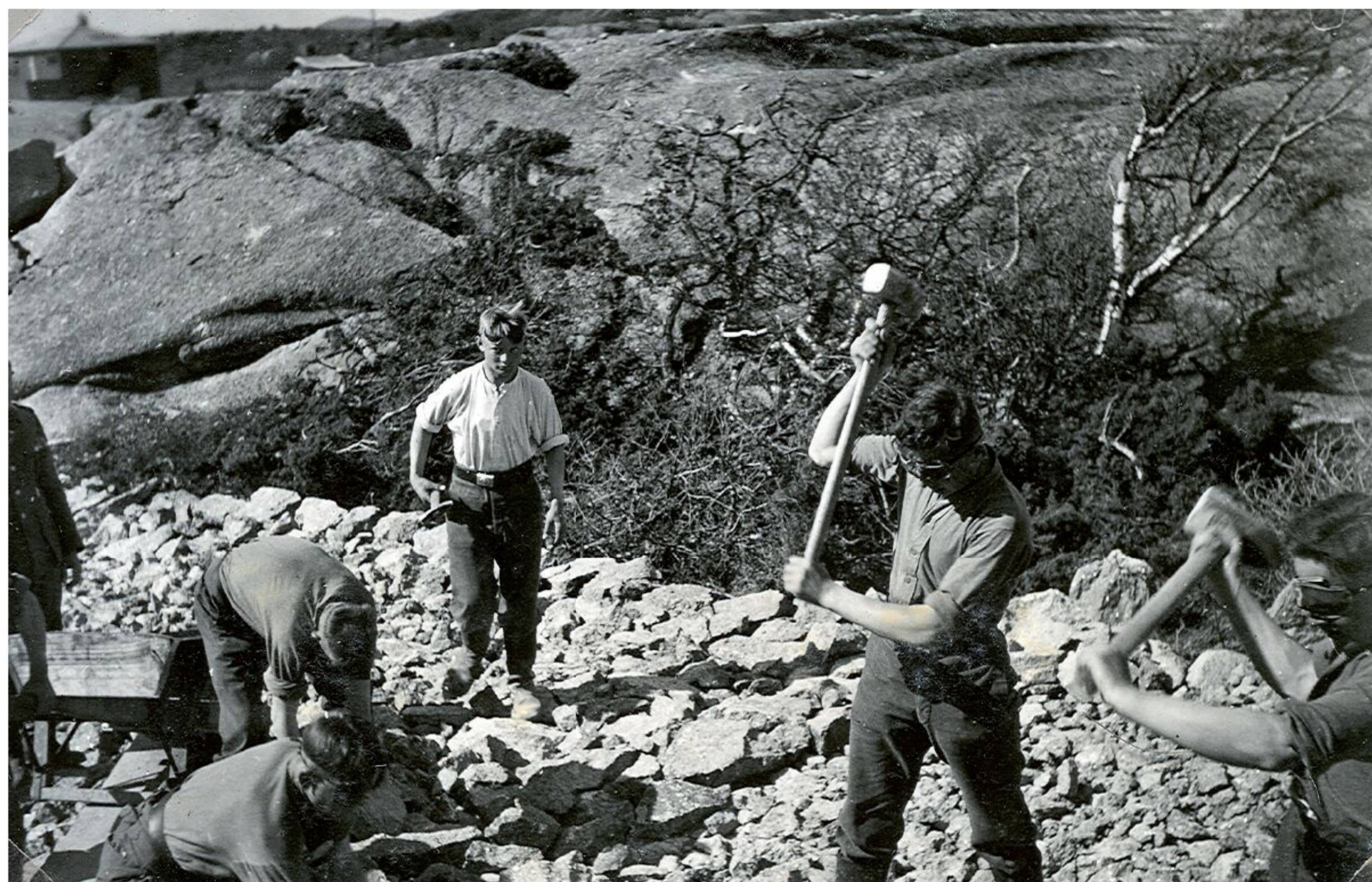
Norske arbeidere bygger vei på Vesteröen fort ved Sandefjord.
