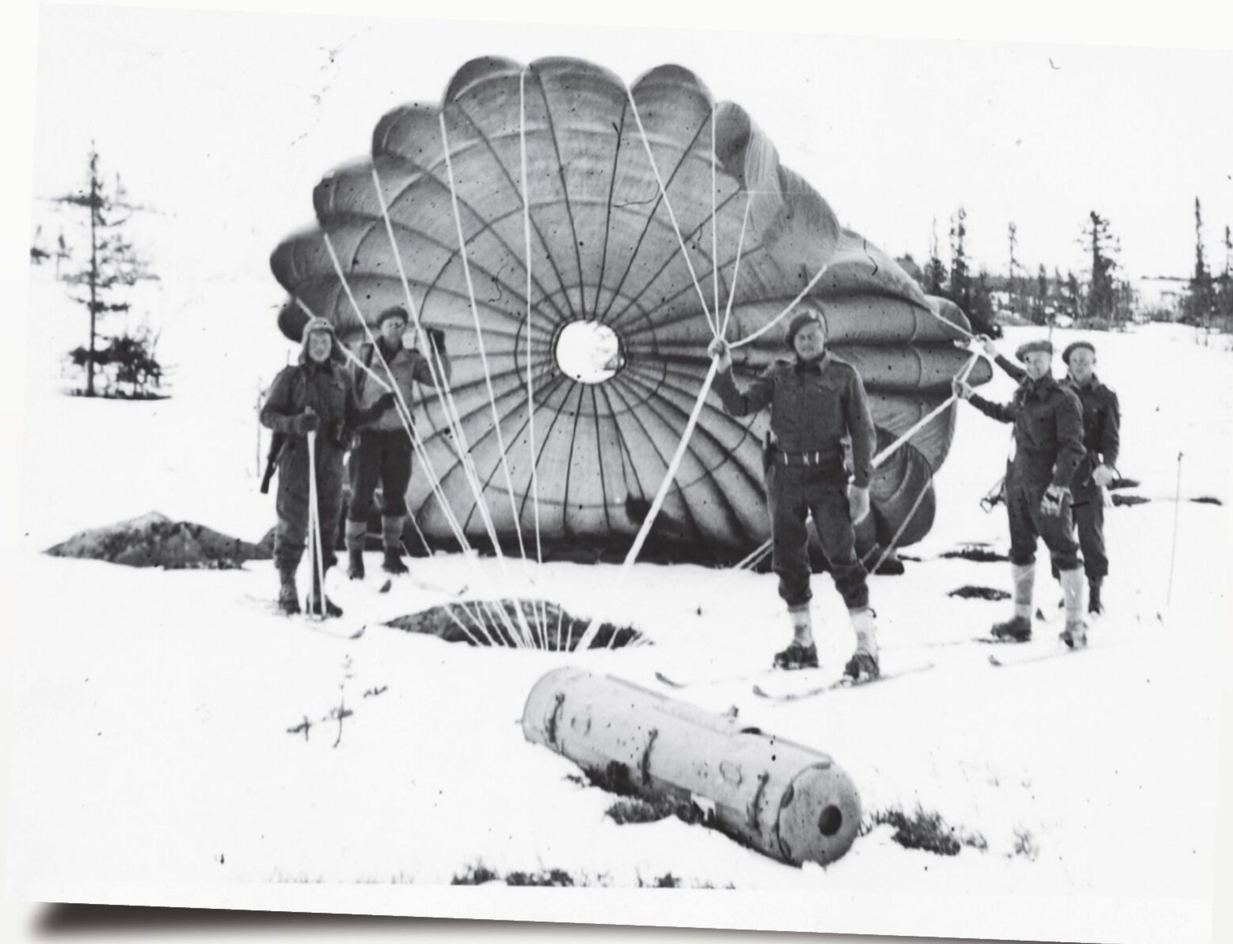
FLYSLIPP: Slipplaget på S for «Sugar». Her ble det tatt imot flere flylaster enn på noen annen dropplass i Norge. I alt ble det sluppet over 20 laster.
