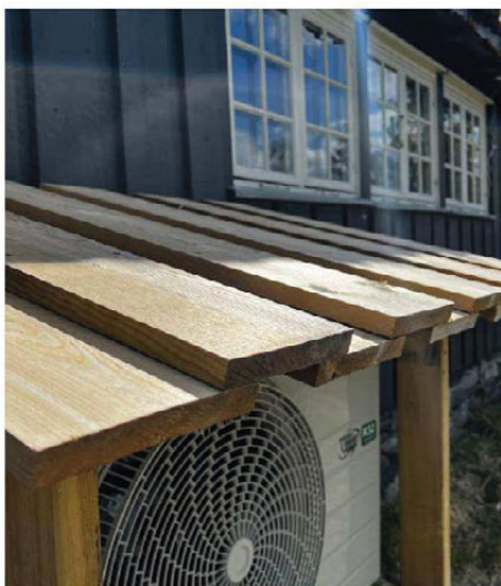
8. Overheng: Taket ble laget med godt overheng. Det gir god beskyttelse til varmepumpen. Bordene ble lagt med ca. 30 mm overlapp.
