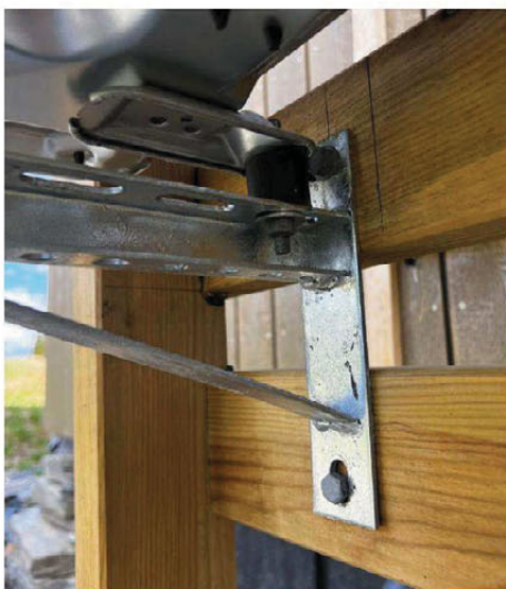
7. Veggbraketten: Vi brukte en standard veggbrakett i stål som ble skrudd til de to bakre tverrbordene med franske treskruer.
