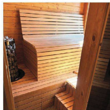
Nybygget: @hyttepagaren gleder seg til kos i badstua som endelig er ferdig.
