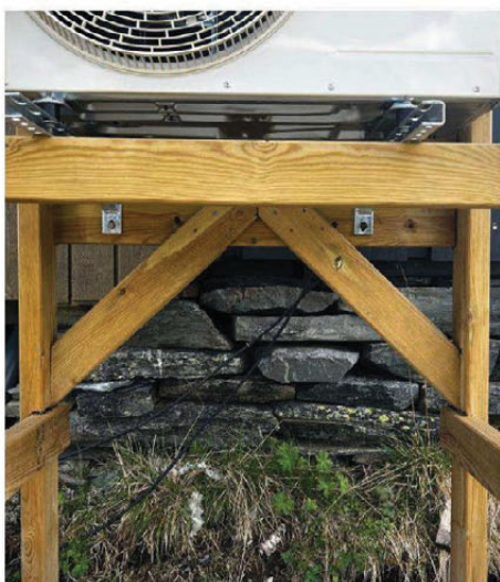
6. Konstruksjon: Veggbrakettene i stål ble boltet fast i de bakre tverrbordene og skrudd fast i det fremre. For å sikre en stiv konstruksjon, monterte jeg også skråbord for avstiving.
