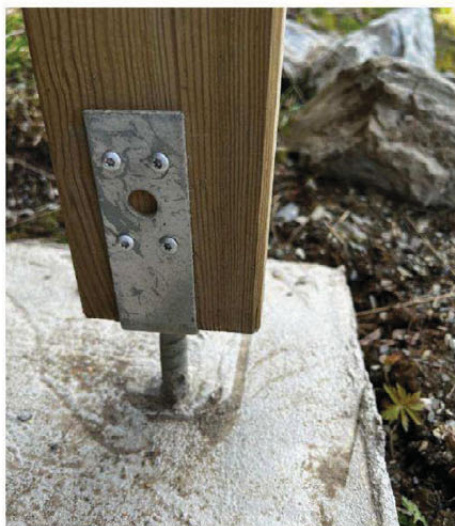
5. Fundament: Vi gravde ned til ca. 70 cm dybde og fylte bunnen med puk. Deretter støpte vi fundamentet oppå dette. Bjelkeskoene ble plassert i den våte støpen.
