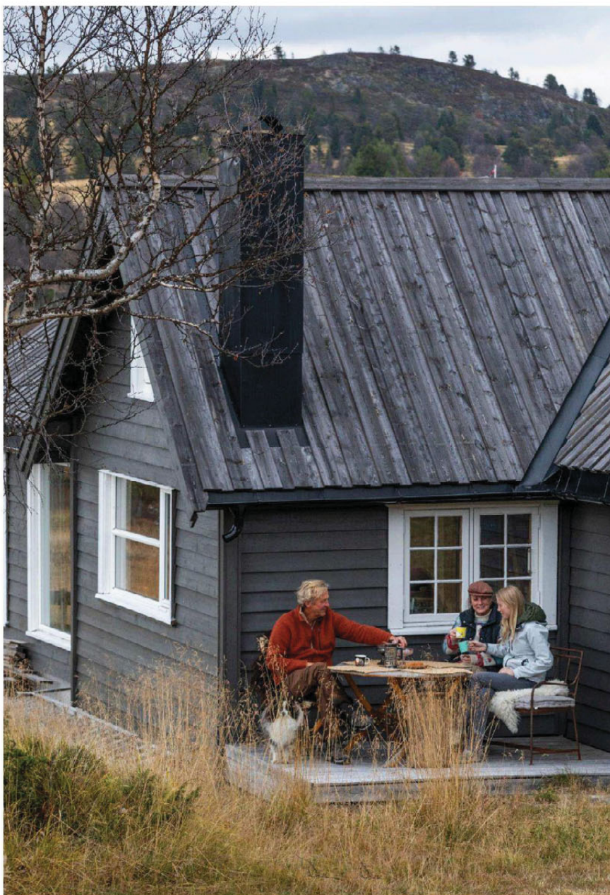
Flott tretak: Den bratte takvinkelen gjorde at det egnet seg dårlig å legge torv på taket, det ble derfor valgt tretak. Her er Morten Andersen på besøk. Han eier nabohytta, som han har vokst opp med.
