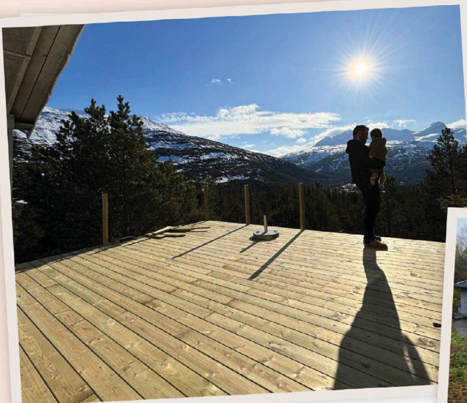
Underveis: Byggingen av verandaen er godt i gang.
