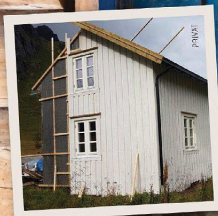
Underveis: Amandahuset får her ny bordkledning.
