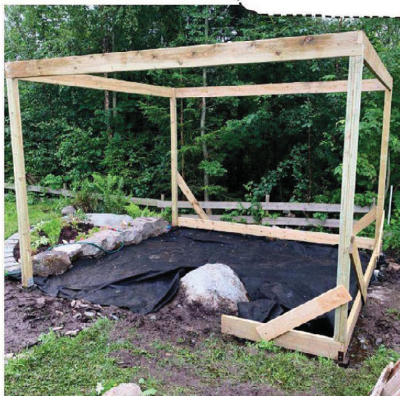
Skjelett på plass: Her er pergolaen i ferd med å reise seg, og duken som skal hindre ugress, er kommet på plass. Det blir inngang kun mot den ene siden av pergolaen. En liten mur av steiner de fant da de gravde, er avgrensning mot hagen til venstre. Der skal pergolaen ellers være åpen, slik at man kan se ut i hagen.
