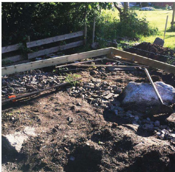
Grunnarbeid: Det måtte en del graving til før hjørnet av hagen var klar for en pergola. I denne hagen må alt gjøres for hånd, da det ikke er mulig å komme til med maskiner. Den store steinen som ses på bildet, lot paret bli liggende.
