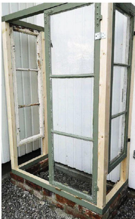
Rammeverk: Lag et rammeverk og fest gamle vinduer fast på sidene. Vinduene i front festes med beslag som gjør at de kan åpnes.
