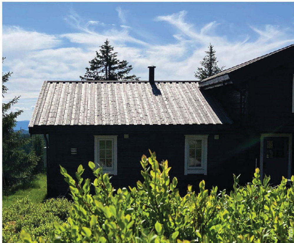
Tett tak: Hvordan vedlikeholder man tretak?
