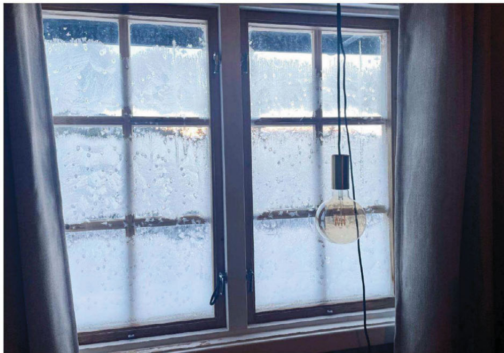
Irriterende: Vinduer som sitter fast er et kjent problem. Utfordringen er størst ved høy luftfuktighet, så blir det ofte bedre om vinteren når luften er tørrere.
