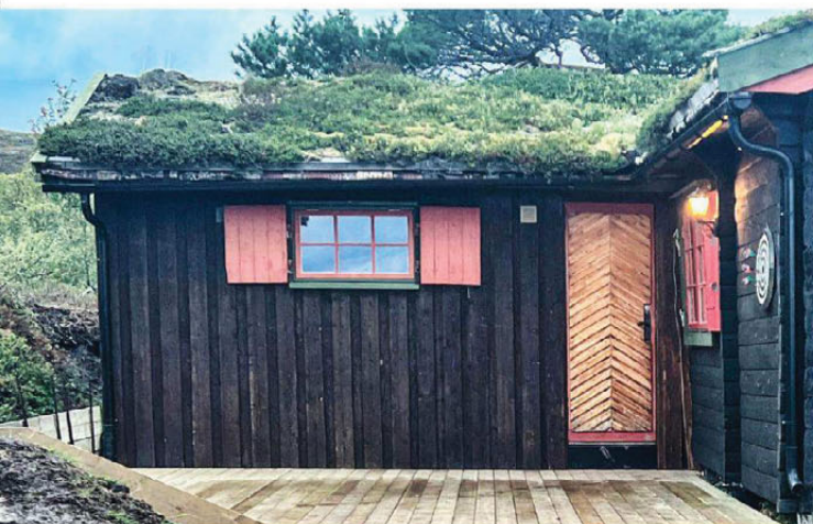
God kombo: Vi kombinerte oppjekkingen med bygging av platting. Da ble pilarene og endene på bjelkene skjult av plattingen.
