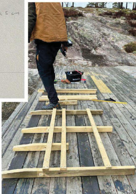
Halveis: En av sidene til sagkrakken er ferdig bygget.
