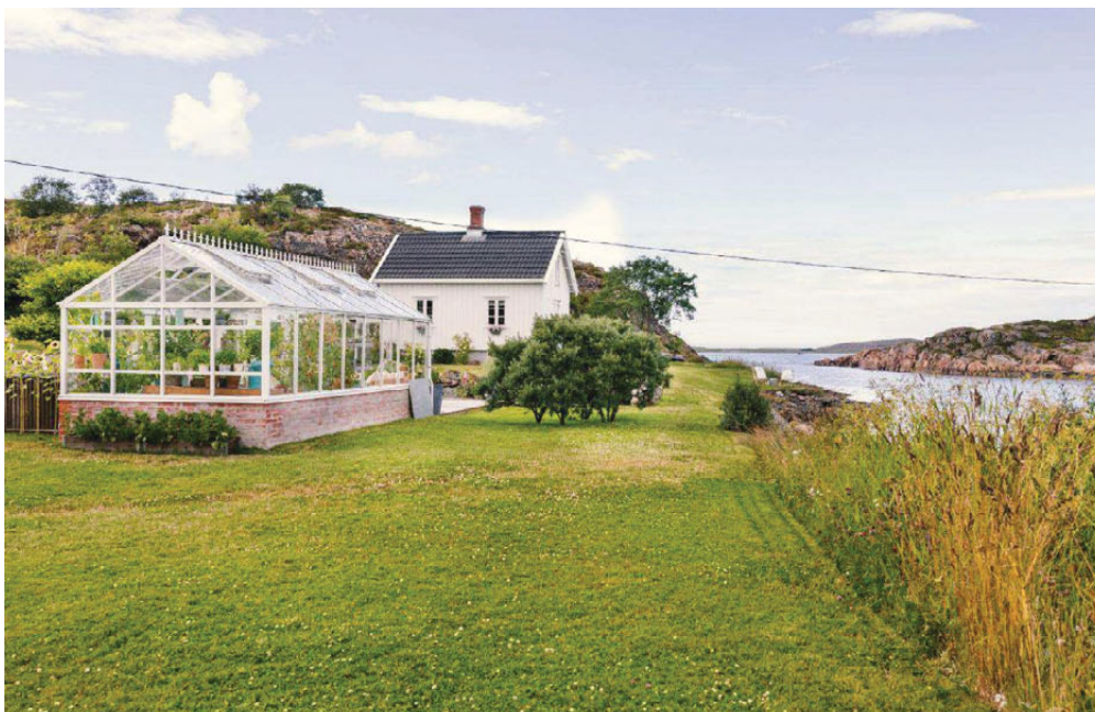
Sommerlig utestue: Drivhuset skulle tåle det værharde kystklimaet og ha et utseende som passet med øvrig bebyggelse på tomte. Valget falt på Green Room Wall fra Willab Garden. Drivhuset er montert på en solid betongplate, og har innlagt strøm og vann.
