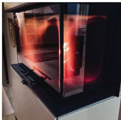
Kresne: Moderne, rentbrennende peiser er ganske kresne både når det gjelder trekk og vedkvalitet. I peiser med store glassflater kan det oppstå soting på glasset.
