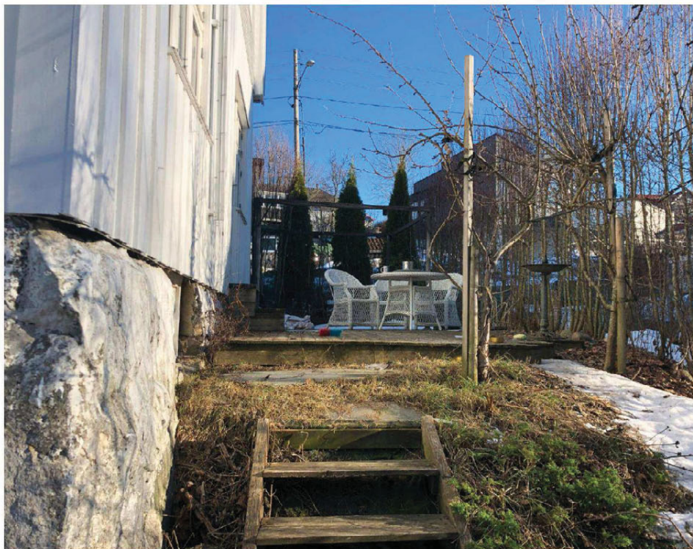
Før-situasjon for hagehjørnet: Slitt platting og midlertidige løsninger for opphold.
