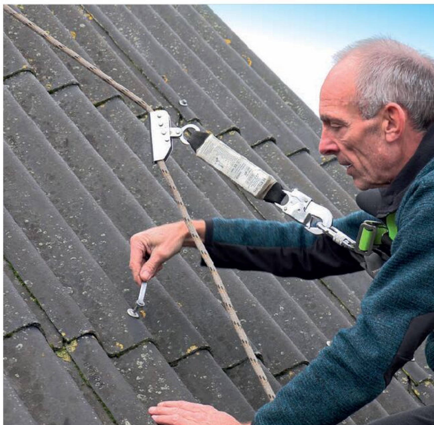
SLIK SKIFTER DU EN ØDELAGT TAKPLATE
