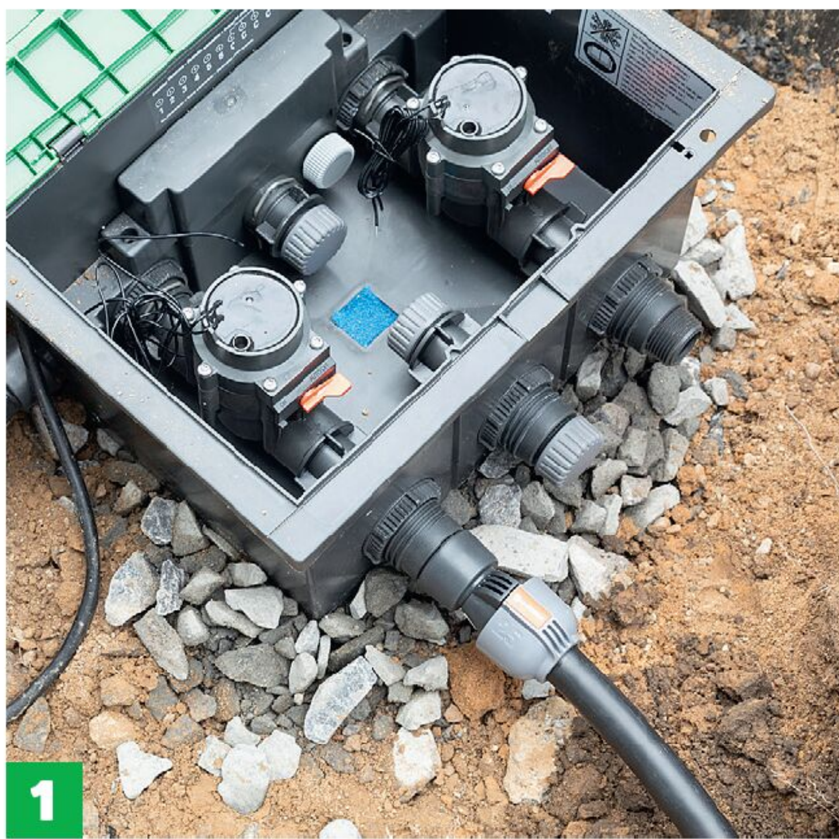
1 Sett en fordelingslange på den første ventilen. Slangen skal lede vann til en sprinkler i plenen. Legg slangen ut i sporet og lag en drenering i midten.
