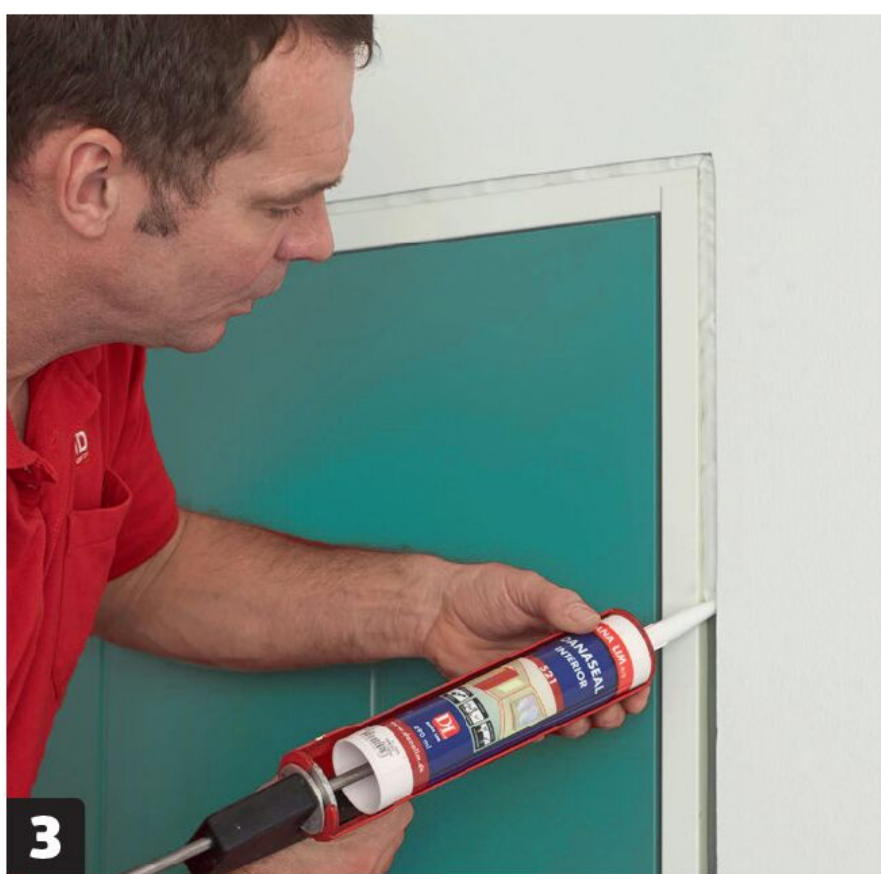
3 Fug rundt døren, slik at sprekken mellom veggen og karmen blir lukket. Hvis du bruker en elastisk fugemasse, vil den også fungere som en effektiv støydemper og stenge lyden ute (eller inne bak døren).
