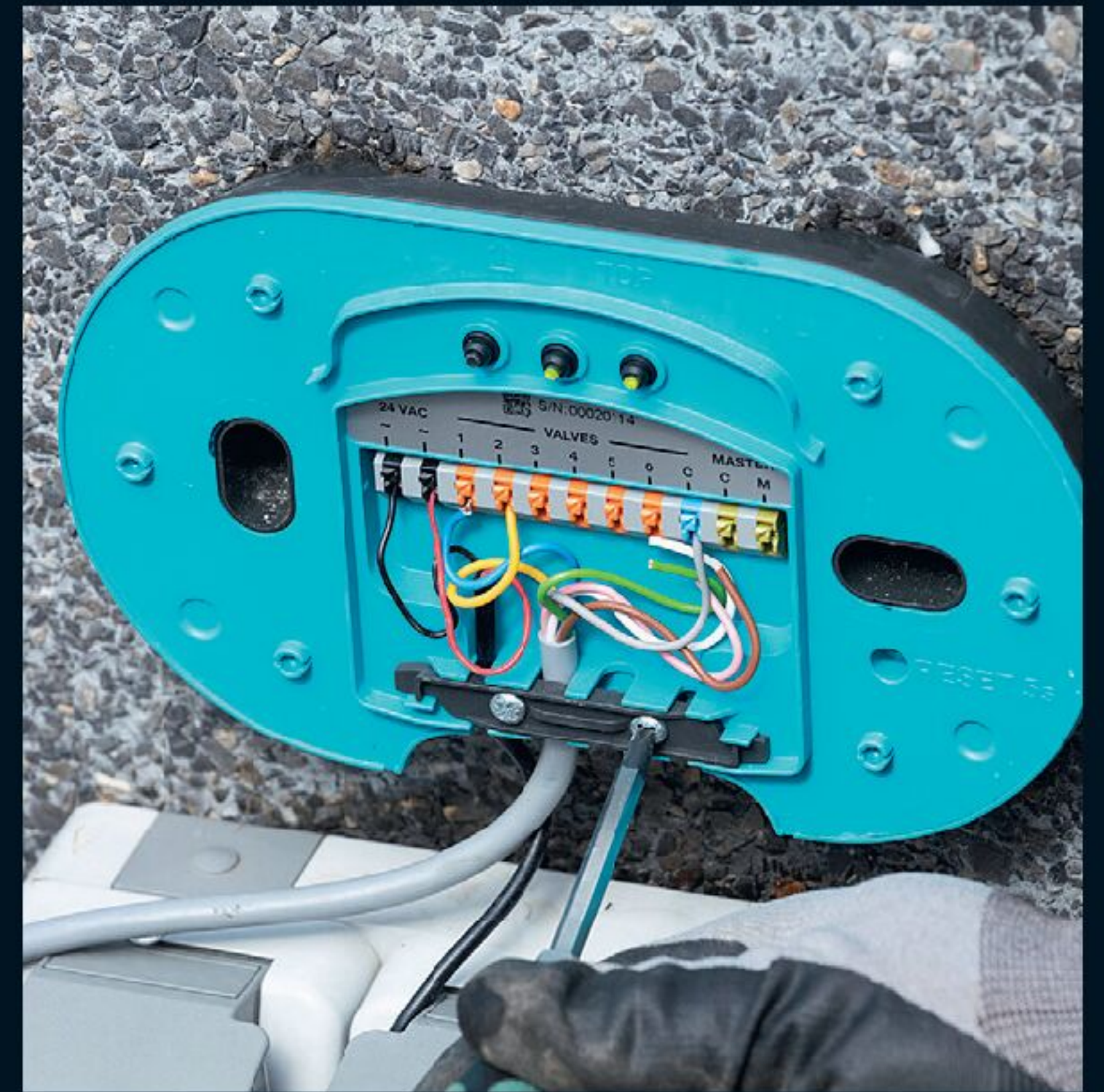
Bluetooth-styringsenheten bør monteres på vegg i nærheten av ventilboksen. Enhetene kobles sammen med en ledning.
