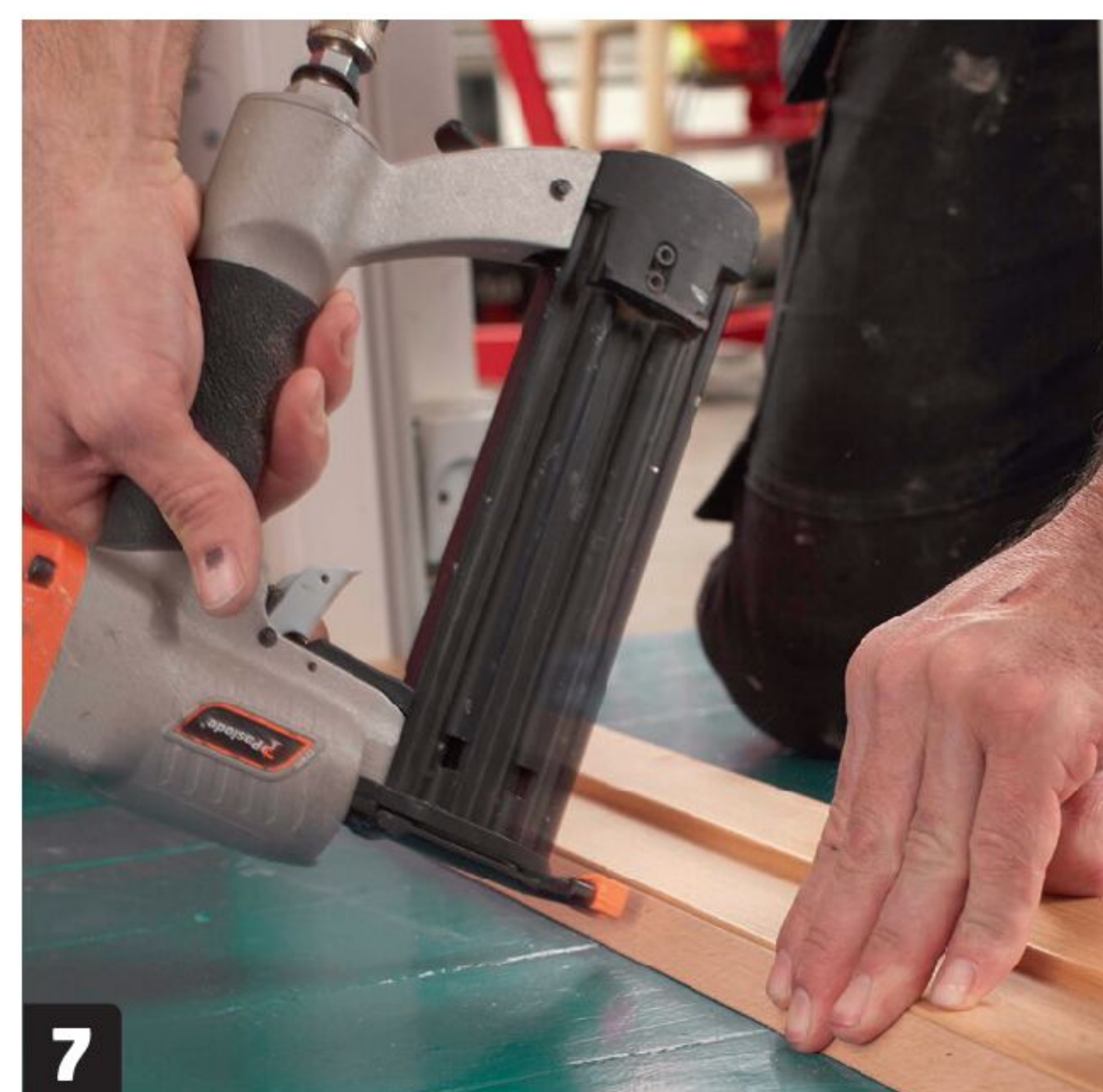
7 Stift listene fast til terskelen. Har du ikke en stiftepistol, kan du bruke dykkert og en hammer. I så fall bør du forbore til dykkertene med et 1 mm bor først.
