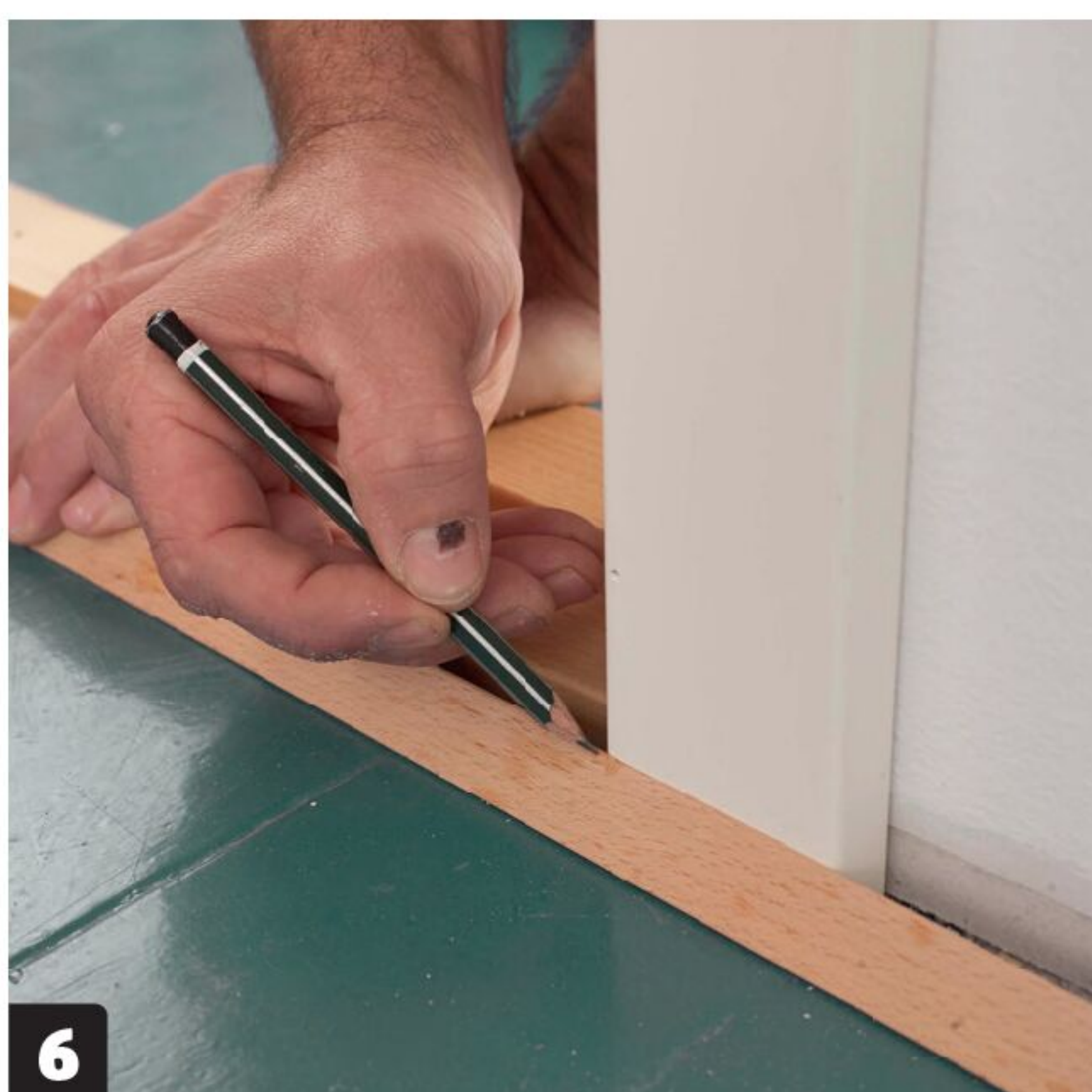
6 Tilpass feielistene. Lag dem 1 mm for lange. Da kan du sette dem på ved å bøye dem litt og sette endene inn først. Da passer listen 100 % når du presser den inn.
