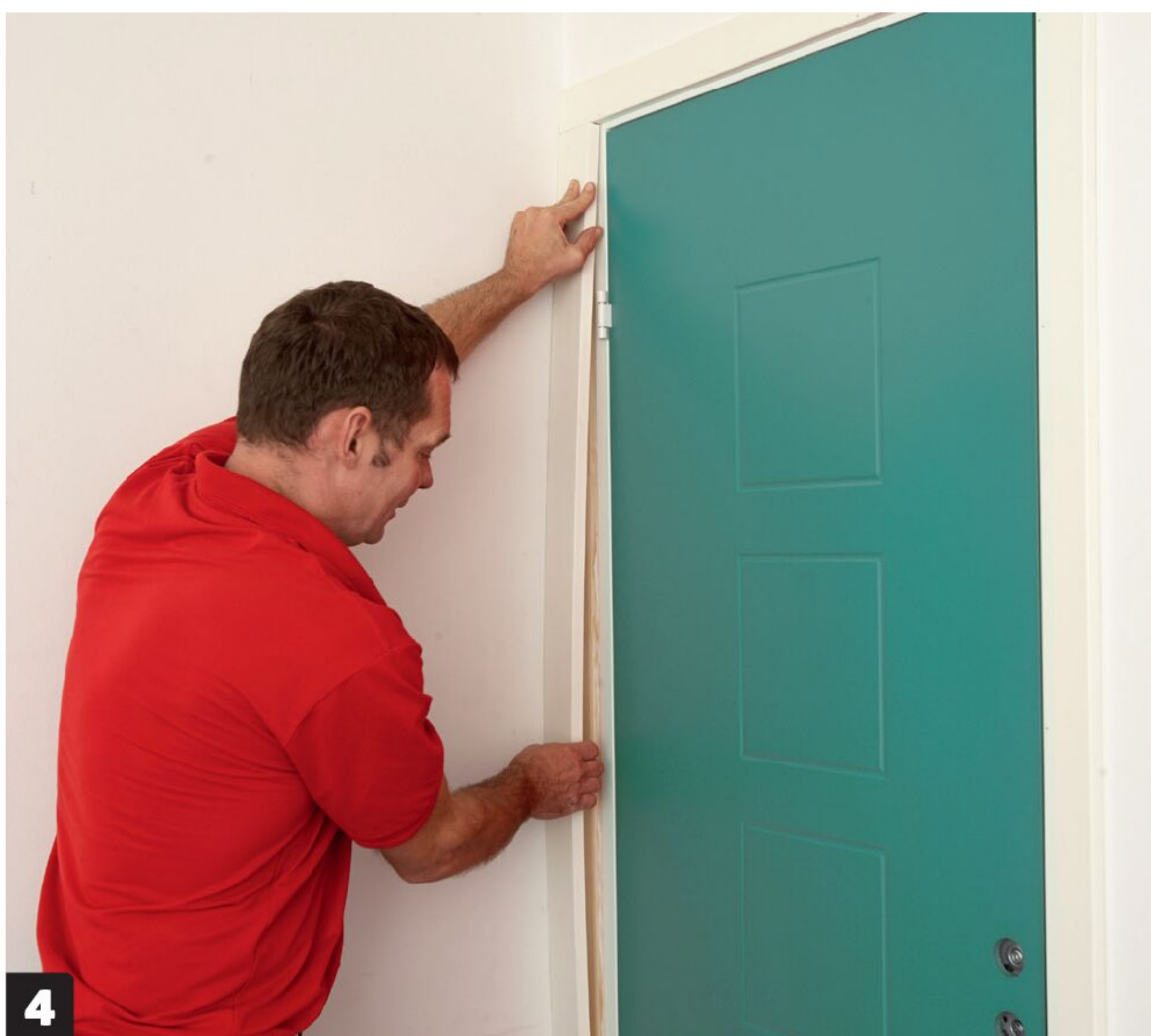
4 Monter karmlister rundt døren. De er kappet i lengder og med 45 graders snitt i hjørnene, slik at du får fine gjærings-skjøter. Listene festes med stifter med for eksempel en stiftepistol. Det går fort, og stiftene er knapt synlige.
